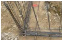
Nœud de chaînage - Continuité mécanique
