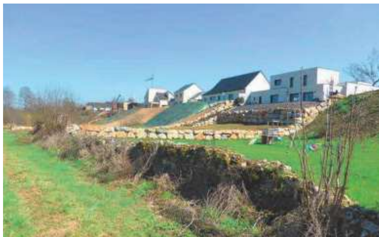
Enrochements massifs et remblais le long du canal (suppression de la frange boisée)
