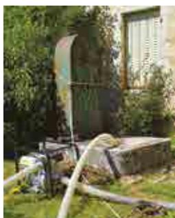
En octobre, la partie manquante de la descente de chéneau correspondant au versant sud de la toiture a été réparée, la liaison avec la citerne rétablie et le terrain débroussaillé. Le remplissage s'est effectué à la faveur des pluies de l'hiver 2021-2022 et l'eau recueillie (soit environ 16 à 17 mètres cubes) a été utilisée pour les arrosages de l'été 2022.
