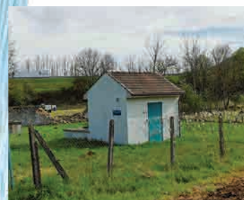
2 - Forage Petit Bon Moisson
