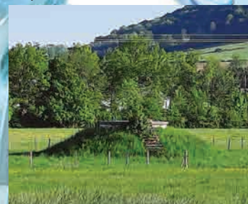
1 - Forage vallée de l'Ouche
