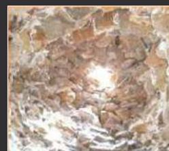
Cette photographie des 3 derniers rangs de lauzes taillées avant montage fait apparaître clairement que les interstices de rangs successifs ne doivent jamais se superposer afin de garantir l'étanchéité parfaite du toit.
