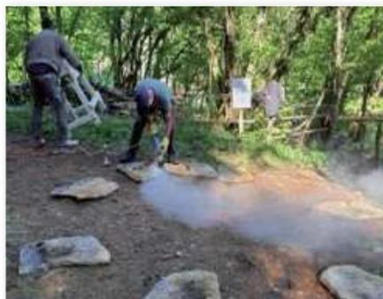
qu'on a découpé toutes les lauzes du premier rang extérieur, on rétrécit le rayon du cercle de 10 cm pour préparer la rangée de lauzes suivante. ... Et ainsi de suite jusqu'au sommet. Ces lauzes ainsi préparées sont ensuite travaillées manuellement pour une adaptation des surfaces et la finition des courbures.
