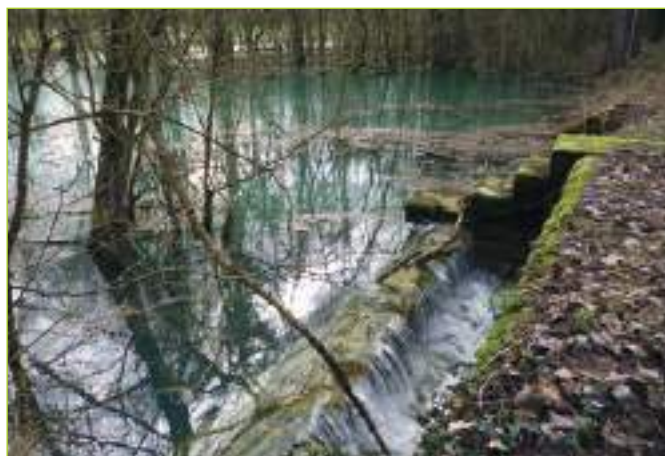
Déversoir, côté Petit Creux de Suzon, avril 2013, photo G. Masson
