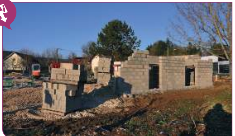
Lancement des travaux de construction de la cellule commerciale « Fil en Fleurs ».
